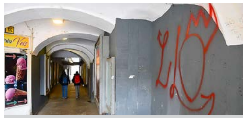
Průchod do Palackého sadů před opravou
