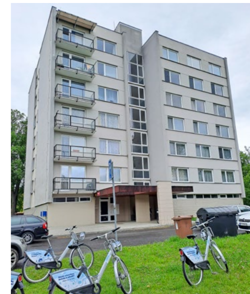
Lipová alej – původní stav domu se sdílenými koly. Kvalitní obklad soklu svíslými pásky kabřince, velkorysá markýza nad vstupem, vyzděné meziokenní vložky v lici fasády ruší efekt pásových oken.
