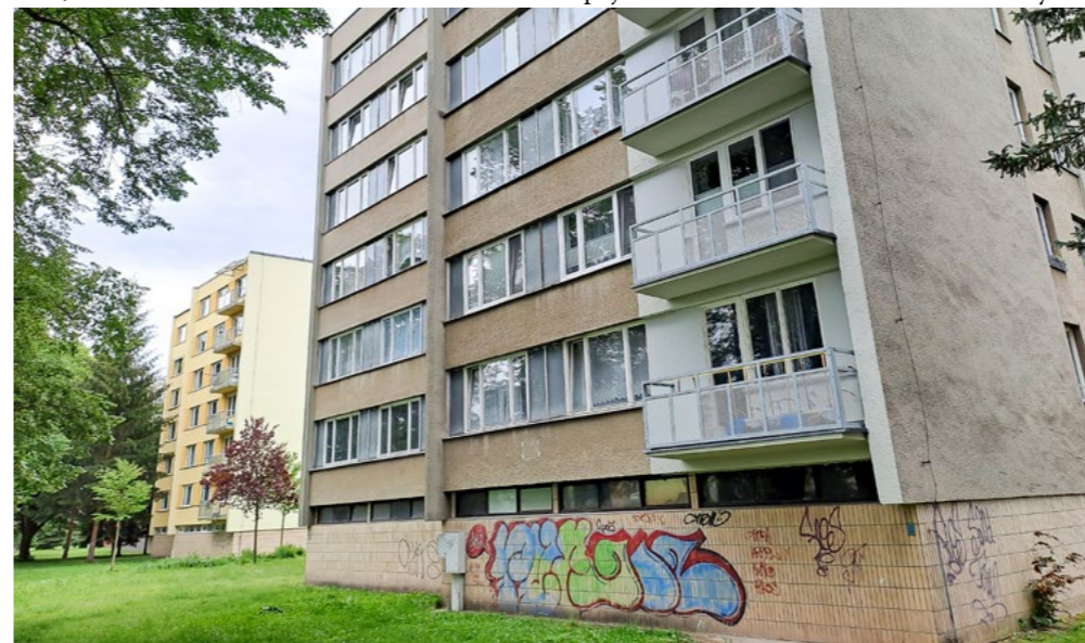
Lipová alej: Atypicky předsazené štíty a omítané fasády s ušlechtilou tvrdou omítkou v kombinaci šedé a béžové – ve výborném stavu, povrch mnohonásobně trvanlivější než zateplení. Nové zavěšené balkony ladí s architekturou domu.
