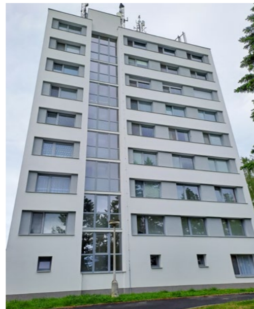
Sídliště Dr. Horákové – zachováno plně prosklené schodiště i zapuštěné pásy oken. Elegantní šedé okenní rámy efekt pásových oken podporují.
