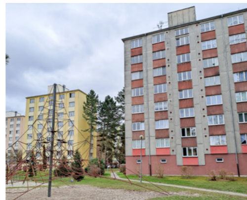
Sídliště Dr. Milady Horákové (dříve Gottwaldův prospekt): Dochovaná fasáda s patrnou skladbou panelů, původním plechovým obkladem parapetů a otiskem bednění z vlnitého plechu na výtahové šachtě. V Německu by takový dům jako poslední příklad svého druhu s největší pravděpodobností chránili. My bychom měli alespoň zdokumentovat (kvalitní foto ze všech stran, portál, vestibul, původní okna, případně dveře). Kultivované zateplení sousedních domů je jednotné a připomíná původní vzhled domu. Při zateplení bude dobré zopakovat původní barevnost a nejlépe i obklad parapetů. Sousední domy by se výhledově mohly vrátit k šedému základu s barevně odlišnými parapety. Kvalitně řešené zateplení s decentními barvami ve hmotě, zvětšení komfortu novými balkony na štítu i průčelí, chvála pultového zastřešení a zachování prosklených schodišť.
