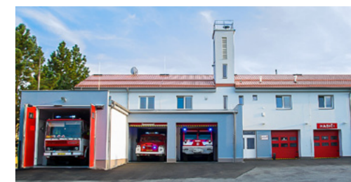
Zrekonstruovaná zbrojnice Protivín (14 mil.)
