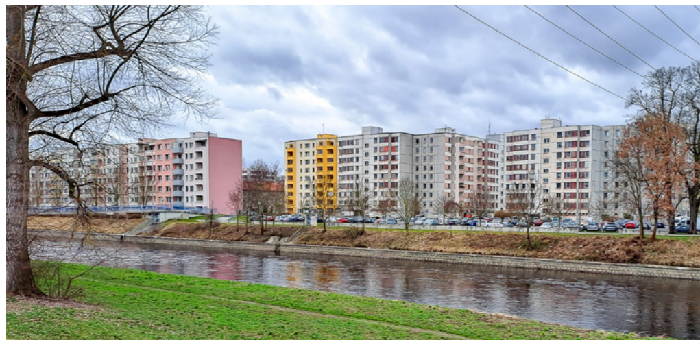
Sídliště Portýč (dříve sídliště Dukla): Vpravo několik intaktních fasád, mezi nimi dobře řešené zateplení se světlou šedou fasádou a cihlově růžovými výplněmi pásových oken. K modernistické architektuře nesedí obloukové zastřešení balkonů. Pětiboké přistavěné lodžie a barevné řešení žlutobílého domu uprostřed potlačily horizontalitu ve prospěch cizorodé vertikality. Tytéž lodžie jsou opticky správně potlačeny shodnou barvou s fasádou. Neobvyklé a zajímavé jsou hmotově jednoduché obdélné balkony vetknuté mezi průčelí a bok rizalitu. Sedá na pozadí cihlové laďi s původní barevností.
