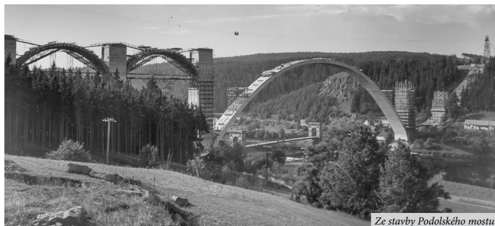
Ze stavby Podolského mostu
